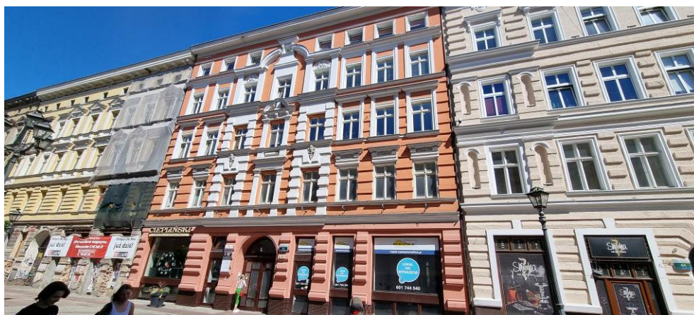
FOT. 1 – Widok budynku od strony frontowej
