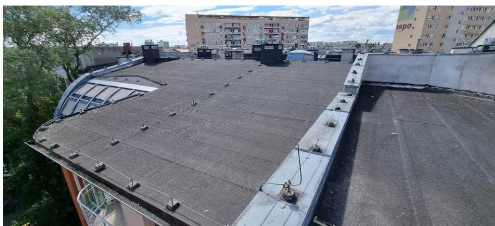
FOT. 3 – Widok połaci dachu od strony podwórza
