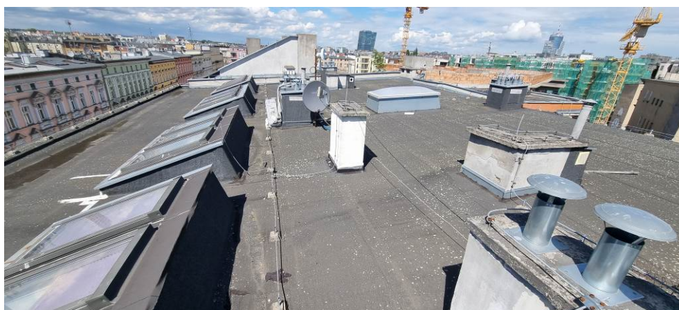
FOT. 2 – Widok połaci dachu od strony pasażu Bogusława X
